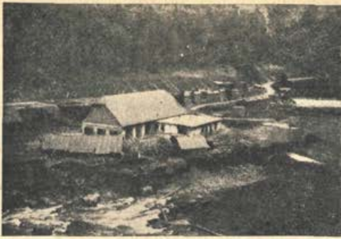
Obnovljena žaga v Soteski (Bohinj)
