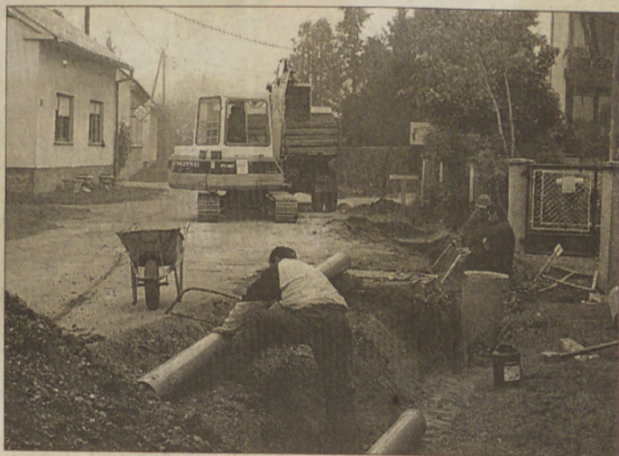
Urejanje meteorne kanalizacije v Nemčavcih
