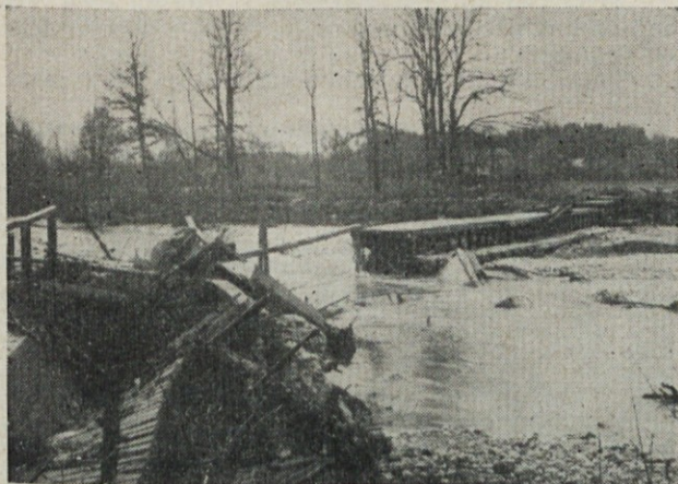
Uničeni jez. Prvo dejanje je končano, v drugem pa bodo nastopili ljudje in stroji, ki naj zasilno popravijo nastalo škodo
