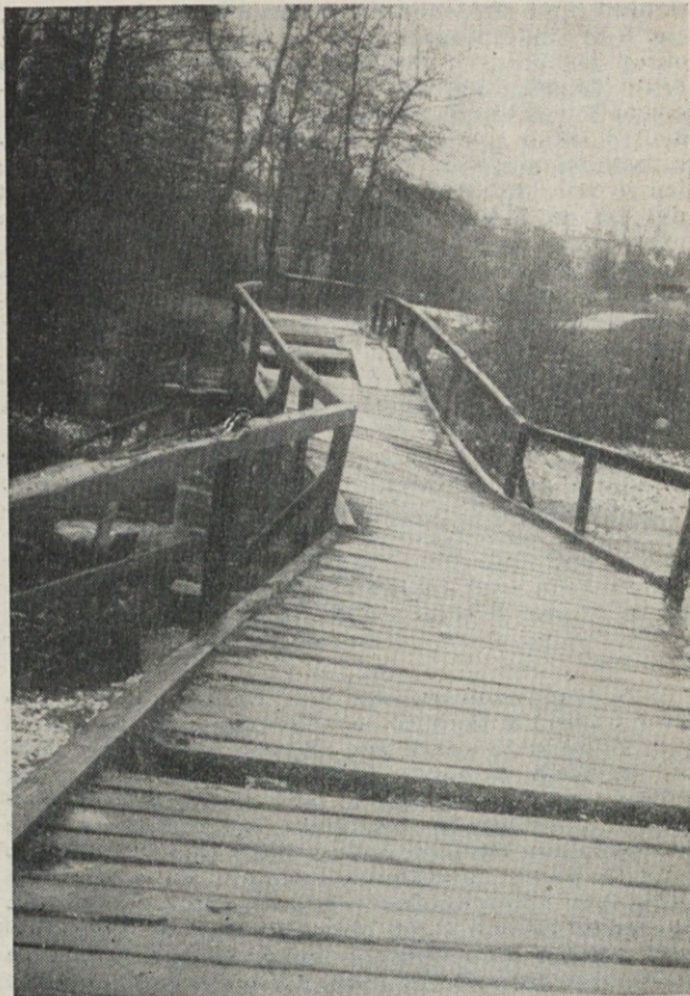
Leseni most, ki je »nekoč« povezoval Homec z Radomljami. Posnetek je bil napravljen po poplavih oktobra letos
