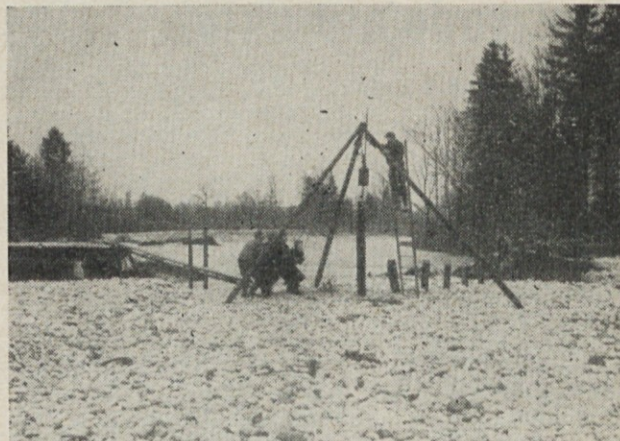
Kader iz drugega dejanja tragedije »Na našem jezcu«. Delavci zabijajo pilote, da ojačijo bodoči provizorični nasip
