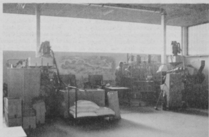
Notranjost proizvodnih prostorov, kjer je še vedno dovolj prostora za stroje
