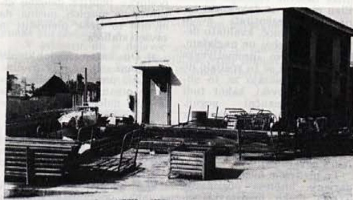
Takoj nasproti urejenega skladišča pa o tem ne bi mogli govoriti. Pri takem neredu je celo dostop v transformator otežkočen
