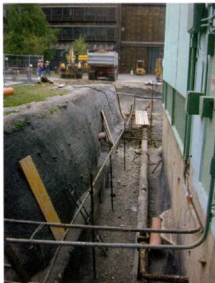
Gradbeno jamo v JE Krško smo zaščitili s sidri, gradbeno mrežo in brizganim betonom, da smo preprečili premike zemljine v neposredni bližini reaktorja, ker bi se le-ta sicer samodejno izklopil.
