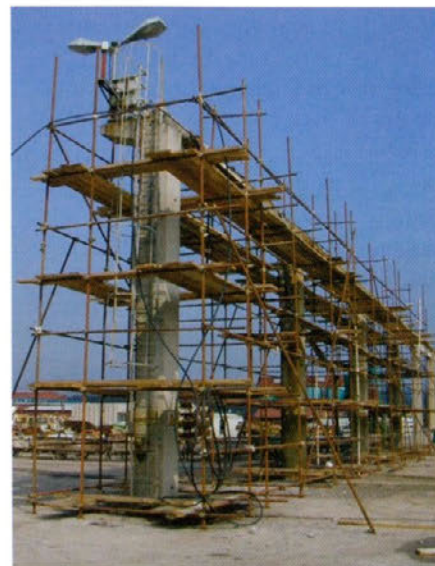
Sanacija in statična ojačitev žerjavne proge na deponiji Premogovnika Velenje – s svojimi delavci in njihovim znanjem smo izvedli sicer strogo specialistične in tipično gradbeniške delovne prijeme.
