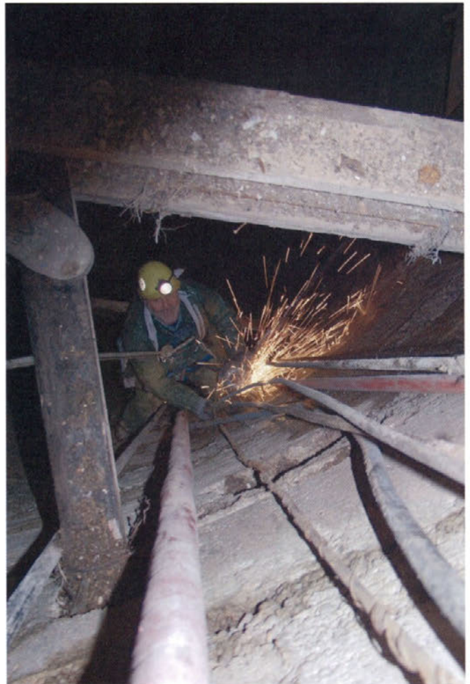
V rudniku Senovo je bilo treba iz jaška pred zasutjem in potopitvijo obzorja odstraniti ekološko sporne električne kable. Spust v jašek in rezanje objemk in kablov so v izredno zahtevnih razmerah opravili alpinisti Šaleškega alpinističnega odseka.
