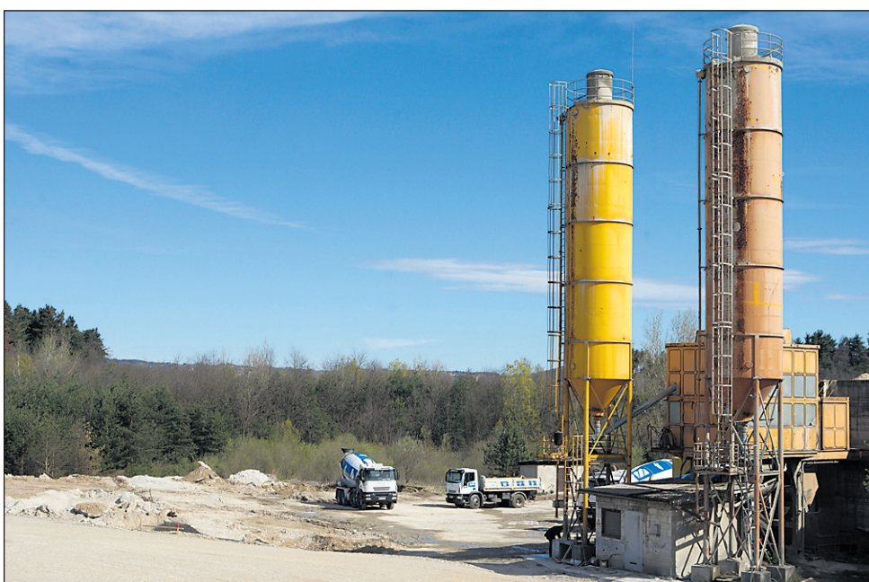
Betonarno na Hajdini, ki je eno od zemljišč, na katerem bo zrasel družinski zabaviščni park, bi morali porušiti že lani, ker je po ugotovitvi inšpektorja črnogradnja. Za njeno obratovanje ni bilo nikoli izdano gradbeno dovoljenje, čeprav so zaposlili zanj.
