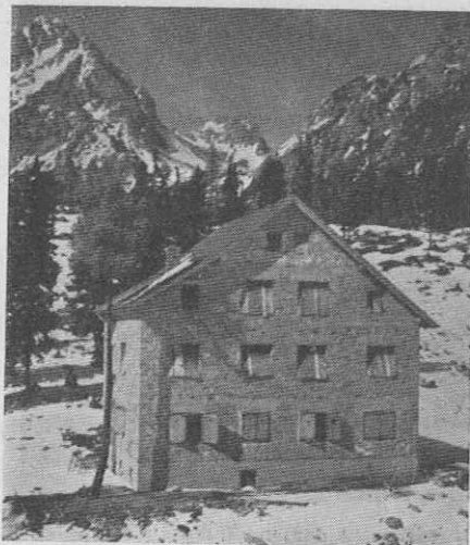
Planinski smučarski dom »Titovi graničarji« na Zelenici (1534 m) — levo Begunjski vrh, v ozadju Srednji vrh, desno Vrtača
