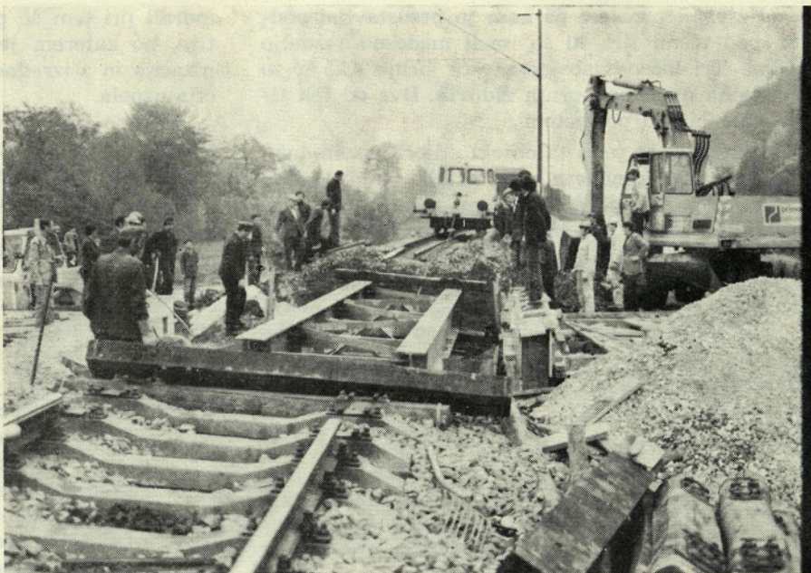
Sl. 1. Vgrajevanje provizoričnega jeklenega mostu
