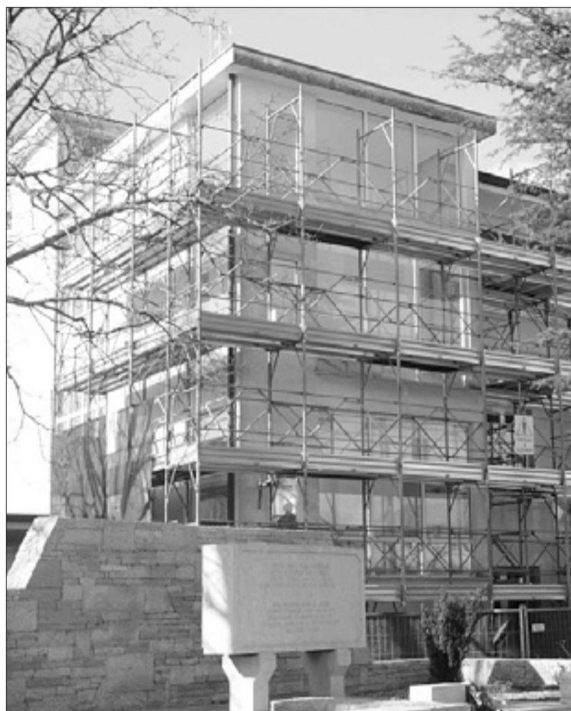
Gradbišče ob nižji srednji šoli v Doberdobu
