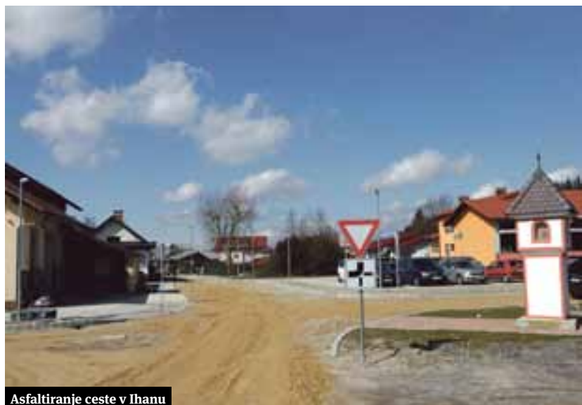
Asfaltiranje ceste v Ihanu
