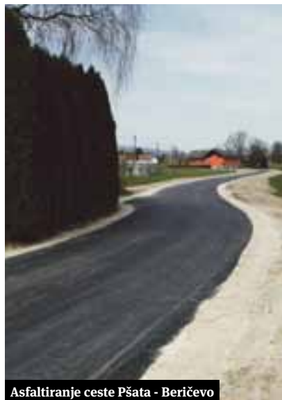
Asfaltiranje ceste Pšata - Beričevo
