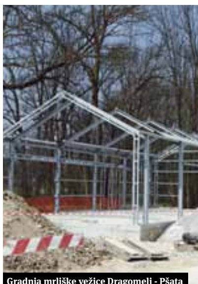
Gradnja mrliške vežice Dragomelj - Pšata
