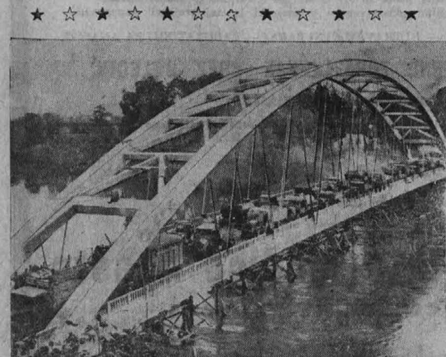
Velik most, ki sloni na enem samem stebri, so izročili prometu v Castelmoronu na Francoskem. Lok meri, od enega konca do drugega, 140,40 in je najvačji na svetu.
