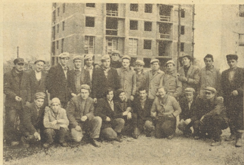
Del kolektiva z gradbišča v Ravnah
