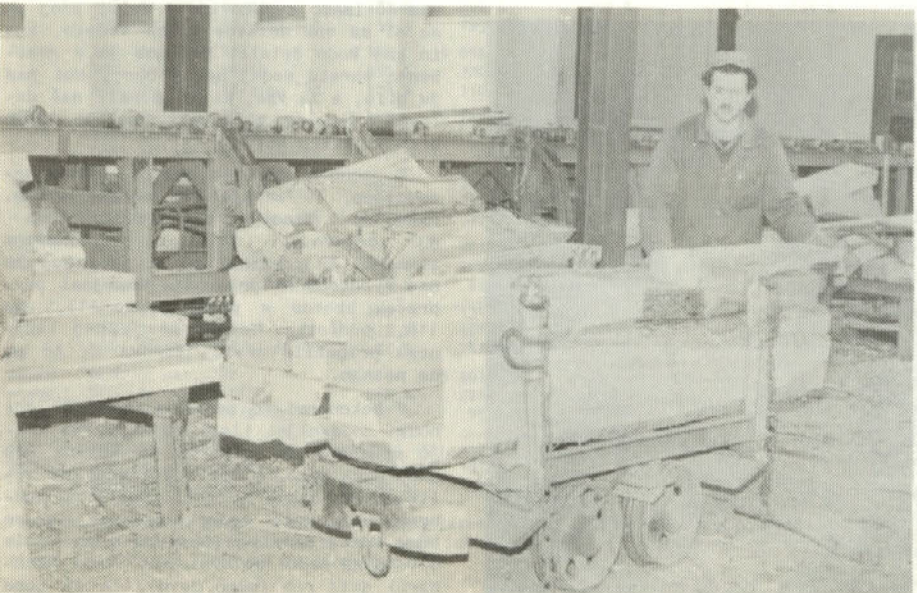
Material za transport v jamo je še treba nalagati na vozičke ročno.
