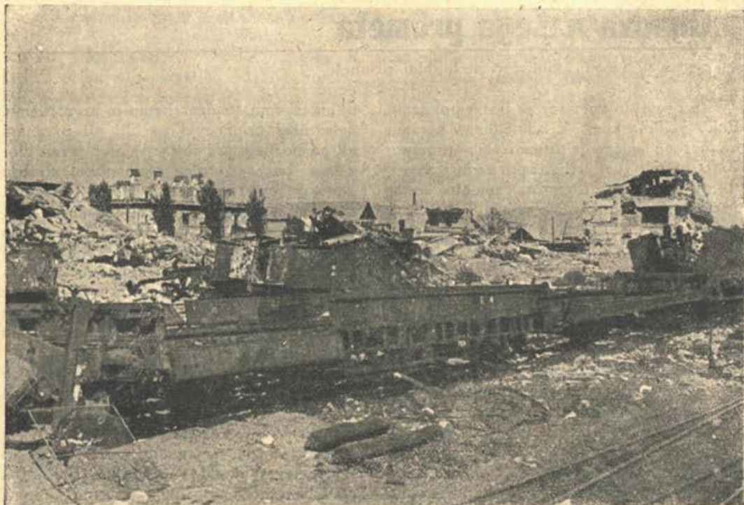
Porušena carinarnica na glavnem kolodvoru v Ljubljani
