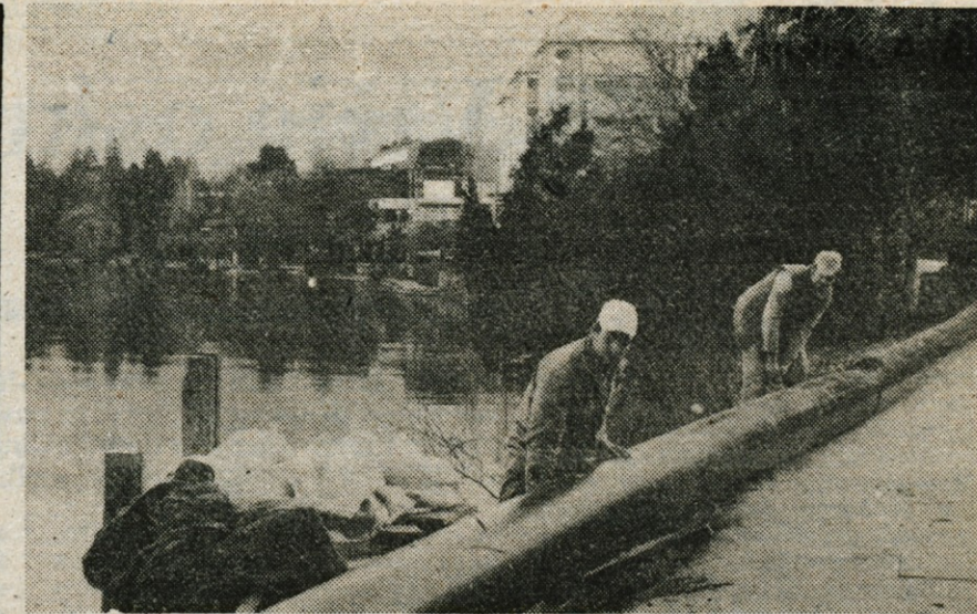
Popravilo stare kanalizacije — Po daljšem odlašnju so na Bledu začeli popravljati stari kanalizacijski vod od hotela Toplice do naselja Mlino v dolžini 1.100 metrov. V skoraj petdeset let staro kanalizacijo je namreč že krepko vdirala jezerska voda. Delo, ki ga opravlja mojster Pelko, bodo končali do junija. Delavce smo pred časom ujeli pri polaganju začasne, dodatne cevi, po kateri v času popravila kanalizacijskega voda odteka odplake, da jih ne požira jezero. — Foto: F. Perdan
