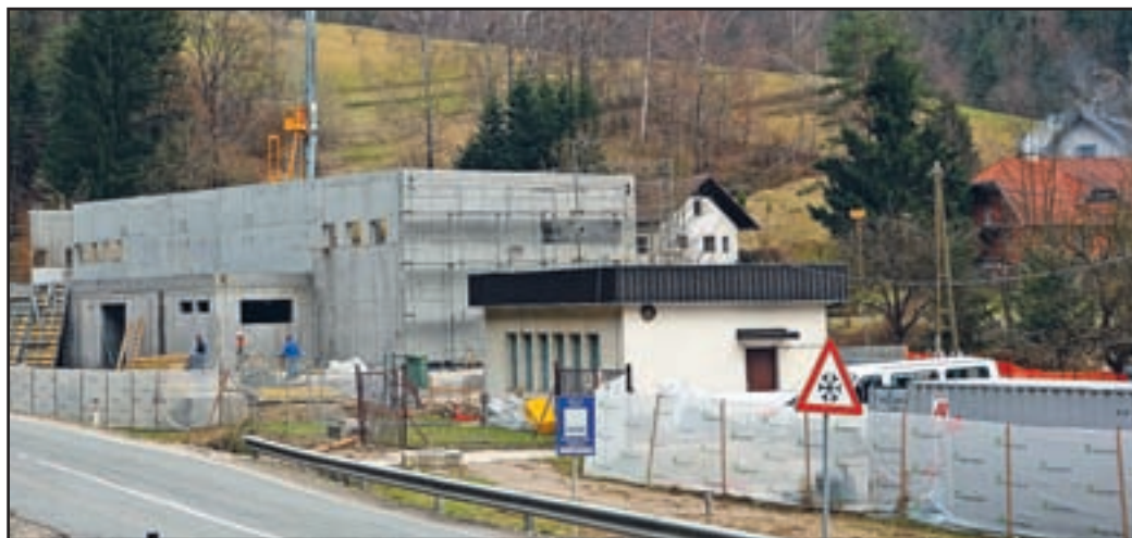
Gradnja kohezijskega projekta napreduje skladno s planom. To velja tudi za čistilno napravo za pitno vodo Čujež v Paki.
