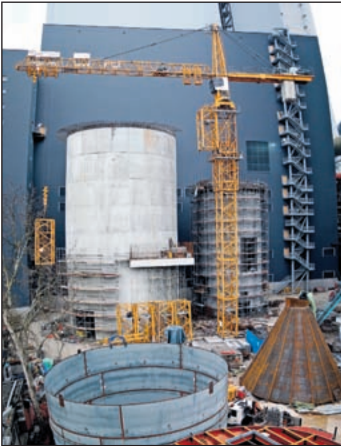
Gradnja šestega bloka uspešno napreduje, trenutno opravljajo hladne zagonske preizkuse.
