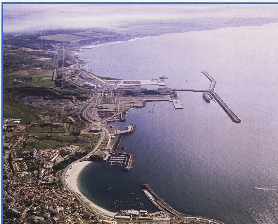
Sprejemni terminal UZP Sines, Portugalska (referenčni objekt TGE)
