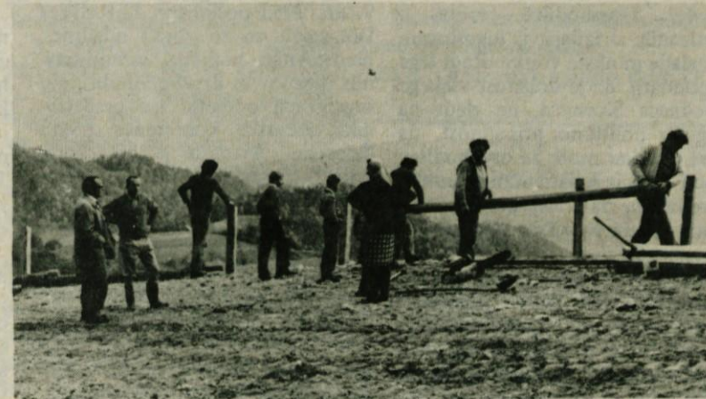
Na razširjenem, do sedaj neprehodnem ovinku, bodo delavci postavili zaščitne bariere, kajti za ovinkom je globok prepad
