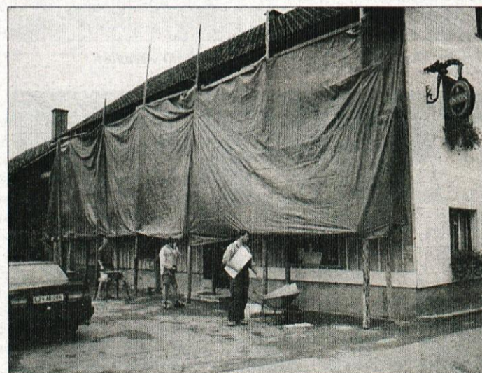
Fasado na Kettejevi hiši v Horjulu je obnovilo podjetje Mizarske in montažne storitve Andreja Kozjeka iz Horjula.
