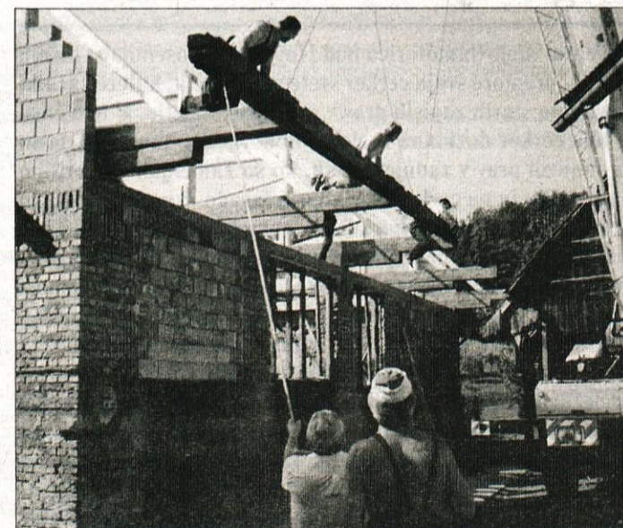
Pomoč sosedov in vaščanov je pripomogla, da je bila živina kmalu v obnovljenem hlevu.
