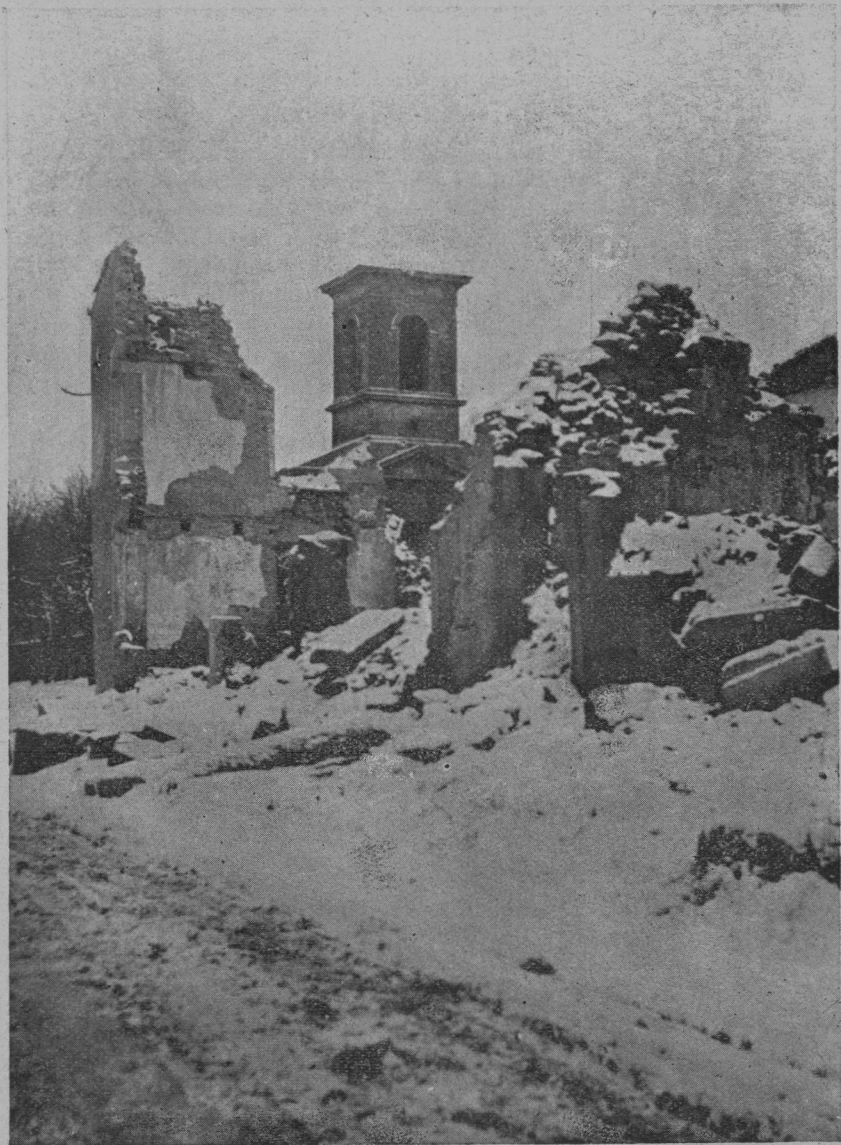
Porušeni samostan na Sv. Gori pri Gorici.
