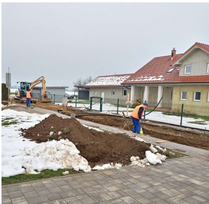
Nadaljevanje izgradnje kanalizacijskega sistema v Lancovi vasi
