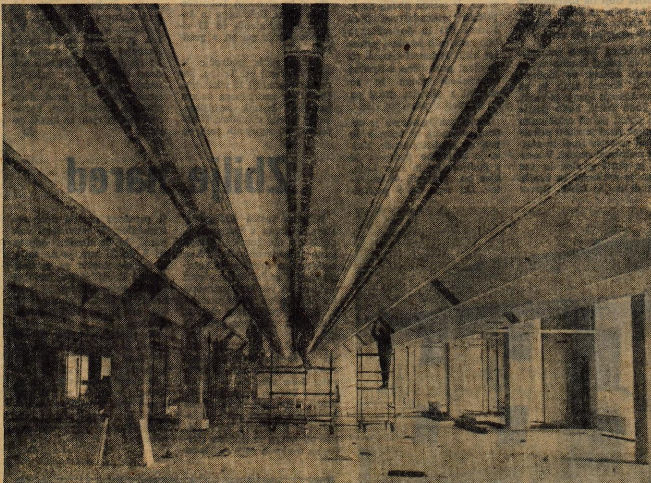
Delavci Elektrotehniškega podjetja Kranj pri elektroinstalacijskih delih v novi veleblagovnici Globus v Kranju
