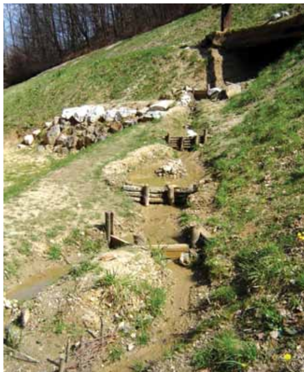
Slika 5: Učni model potoka, kjer so uporabljeni ERM sistemi: vrbovi popleti za stabilizacijo brežin, peščeni otoki za razgibanje toka vode, brzice za prezračevanje vode in meandri za zastajanje vode (vir: Limnos arhiv, 2010).
