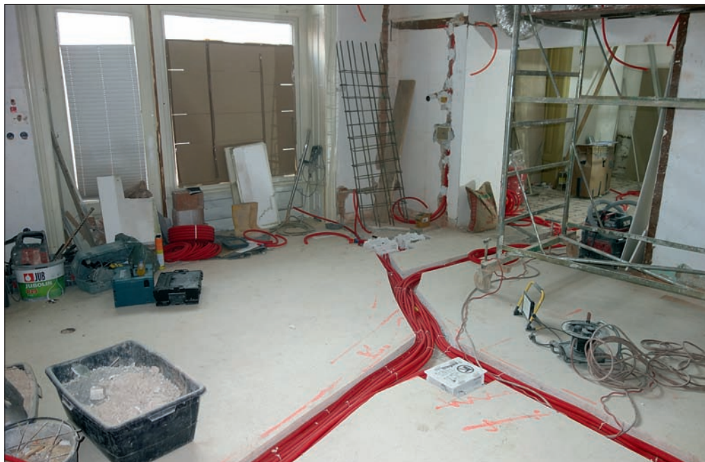
Slika 2: Obnovitvena dela v Gosposki dvorani januarja 2024.
