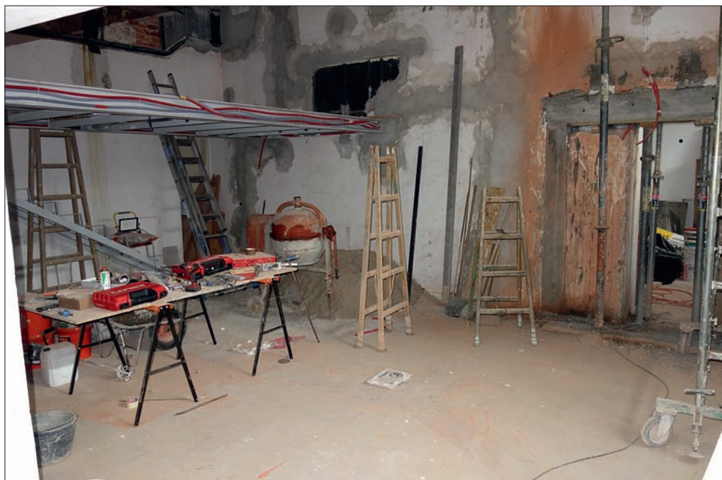
Slika 3: Obnovitvena dela v Gosposki dvorani januarja 2024.
