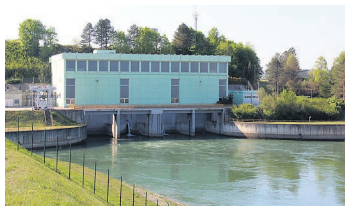
Med osmimi veliki hidroelektrarnami na Dravi največ električne energije proizvedeta HE Zlatoličje in Formin, obe skupaj letno dobrih 40 % celotne letne proizvodnje DEM.
