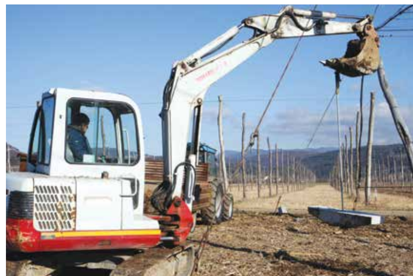
Pri obnovi hmeljske žičnice pri Rojnikovih v Sp. Grušovljah
