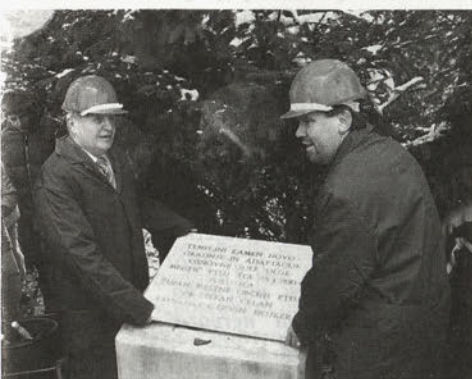
Ravnatelj šole in župan sta 23. januarja položila temeljni kamen. Foto: Aleš Šprah.
