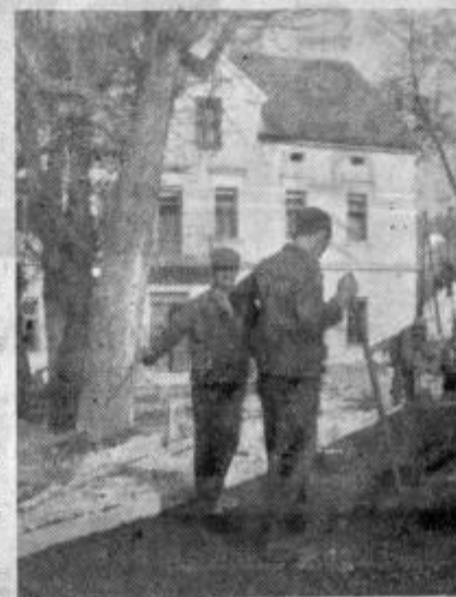
Asfaltirna skupina med delom na cesti v Smarju
