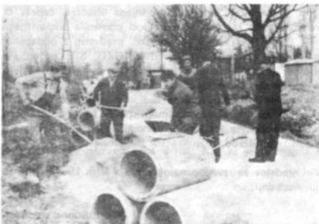
Krajan s prostovoljnim delom gradijo kanalizacijo
