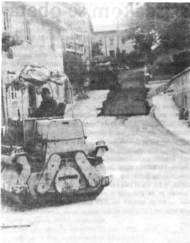
Asfaltiranje ceste v Jurčičevi ulici
