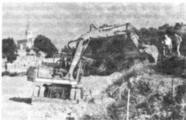
Zemeljska dela za igradnjo betonskih tribun
