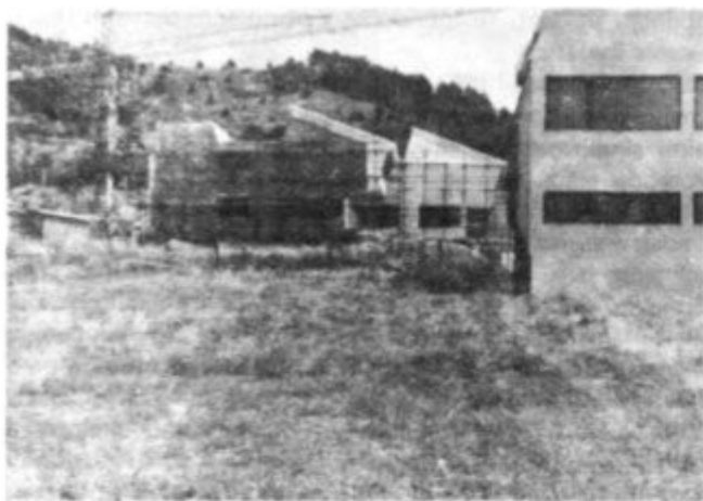
Zadnja finalna dela pri izgradnji dela II. faze nove osnovne šole
