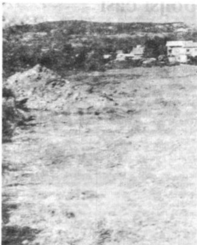
Pripravljalna dela za sejmišče v Rečici
