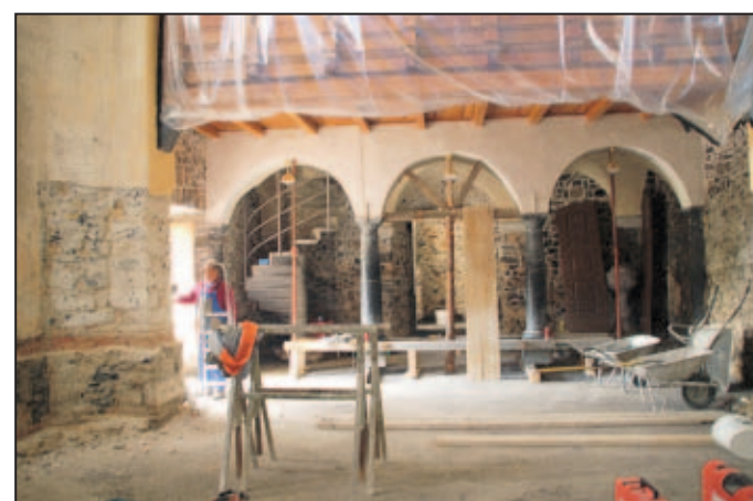
Obnovitvena dela v horjulski farni cerkvi
