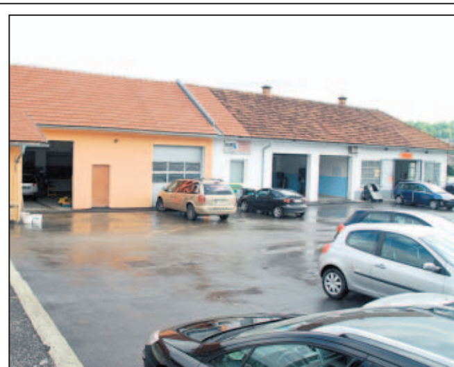
Urejeno dvorišče in obnovljene delavnice mladih podjetnikov.
