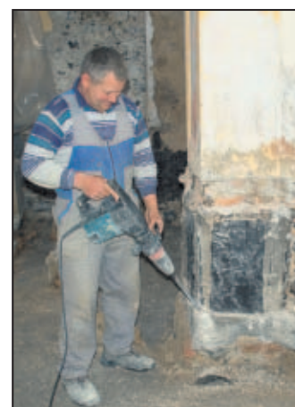
Strojno odstranjevanje vlažnega ometa
