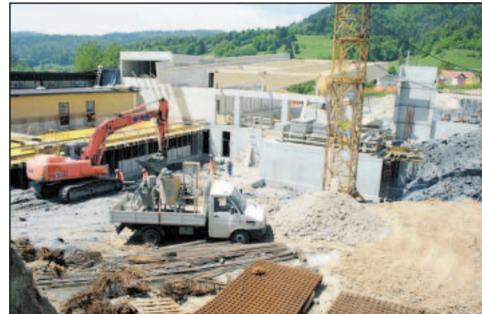
Pogled iz druge strani gradbene jame.
