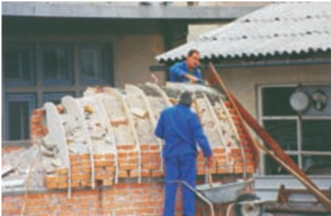
Slika 12: Izdelava hidravličnega modela omočenega dela lupine v merilu 1:1. (foto: Primož Banovec) Building the hydraulic model of the wetted part of the shell in scale 1:1.
