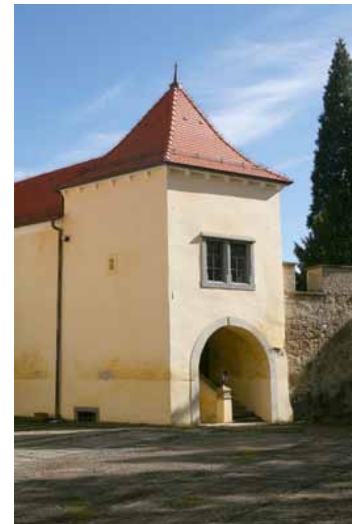
Stolpasti objekt nekdanjega upravnega trakta. Foto: Branko Vnuk 2010.
