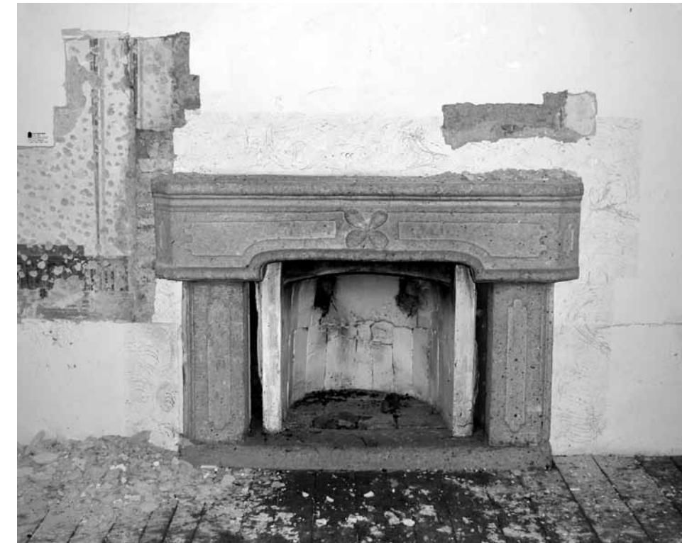
Nekdanji damski kabinet s kaminom. Stanje 1. 3. 2010. Foto: Branko Vnuk 2010.
