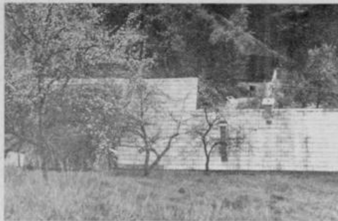
Zadaj nad domačijo je zazijala globoka razpoka, ogromna plast ilovice že pritiska na zidove
