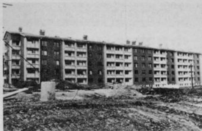
Končan je objekt B 4
