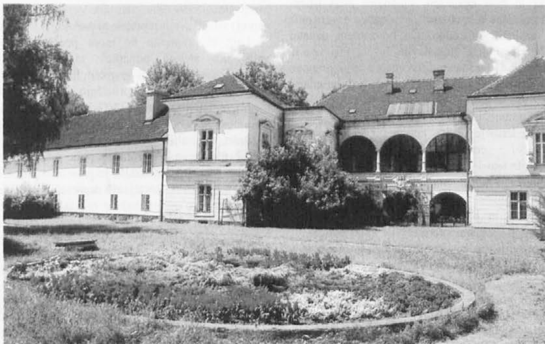
GRAD RAVNE Ravne na Koroškem
