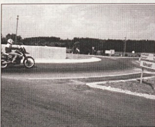
To krožno križišče v Sinči vasi buri duhove; ali bodo beton odstranili?
