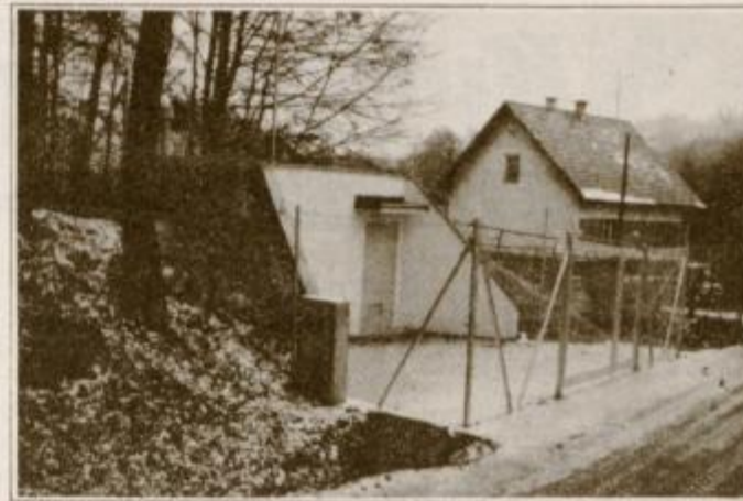
Prečrpalna postaja pitne vode v Grajeni. Foto: M. Ozmeč
