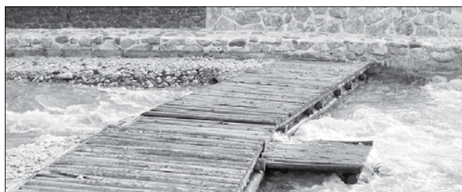
Namesto, da bi Savinja tekla preko jez, si je skopala pot pod njim.
