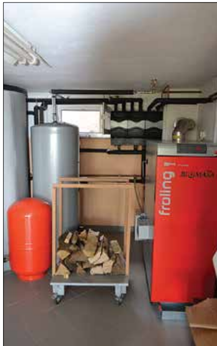
Kotel na polena Fröling S4 z avtomatskim vžigom, hranilnikom toplote in bojlerjem za sanitarno vodo
