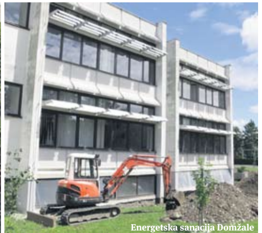
Energetska sanacija Domžale
