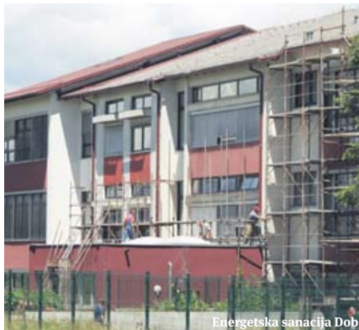
Energetska sanacija OŠ Dob
