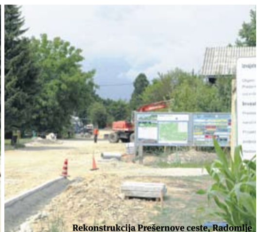
Rekonstrukcija Prešernove ceste, Radomlje
