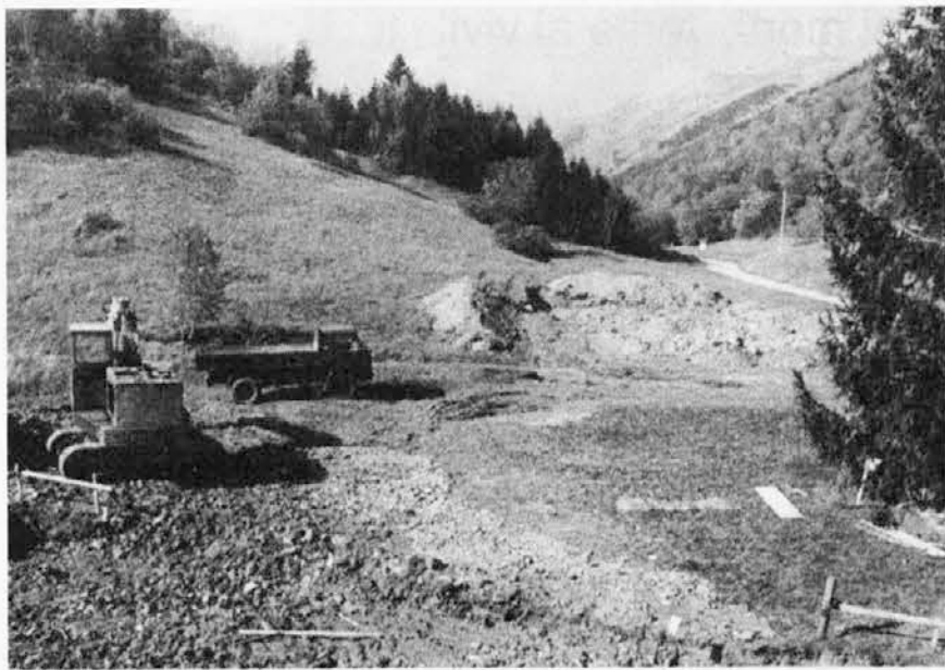
L'inizio dei lavori per il rifugio di passo Solarje, nel comune di Drenchia
