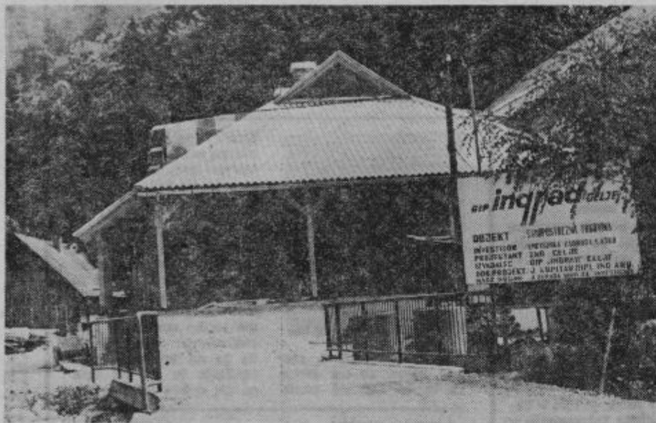
«LEPOTICA» MED GRADNJO. V Jurkloštru dokončujejo obrtniška dela pri izgradnji nove trgovine, ki jo je po lanskoletnem požaru začela graditi Kmetijska zadruga Laško. Nova samopostrežnica s potrebnimi skladišči, bifejem z verando, stanovanje za trgovce in klubski prostor za krajevne organizacije in društva. Objekt gradi GIP »Ingrad« iz Celja. Otvoritev bo ob prazniku občine Laško.
