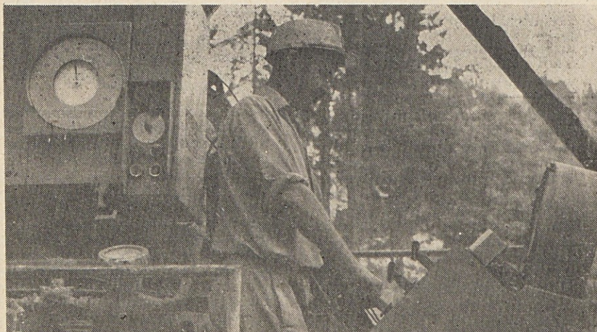
Strojnik pri upravljanju betonerskih strojev Lescha in Aliva, na gradbišču OSRD na Pleskem. Foto: inž. Bregant Tone
