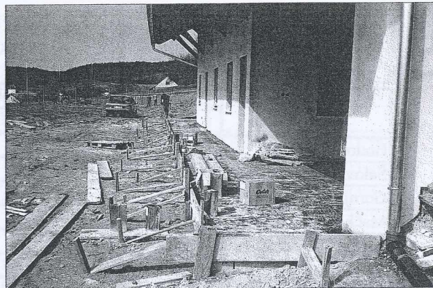
Izgradnja igrišča s slačilnicami v Stanjevcih
