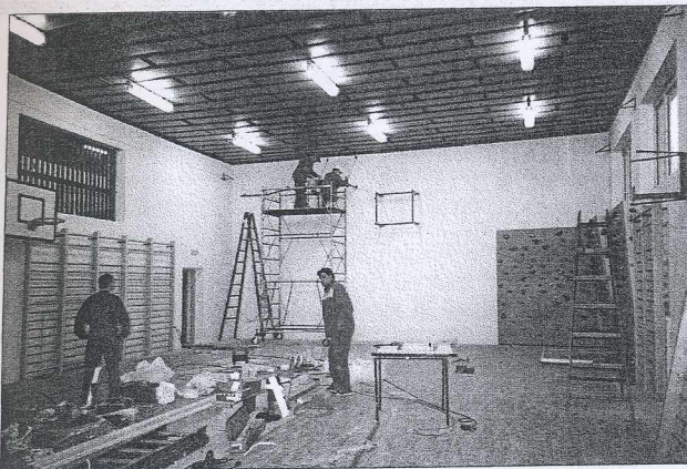
Takole je potekala obnova telovadnice v osnovni šoli G. Petrovci
