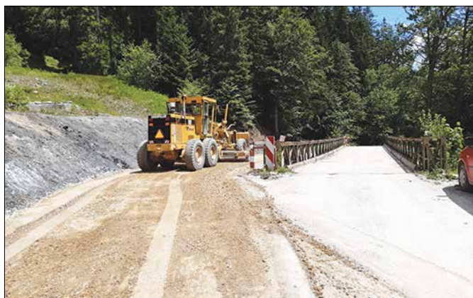
Obvozni odsek mimo mostu omogoča tudi težji tovorni promet.
