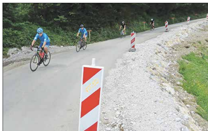
Rečiška občina je za sanacijo plazu pridobila 179 tisoč evrov nepovratnih sredstev.
