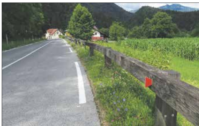
Nove prekinjene bele črte opozarjajo voznika na rob ceste.
