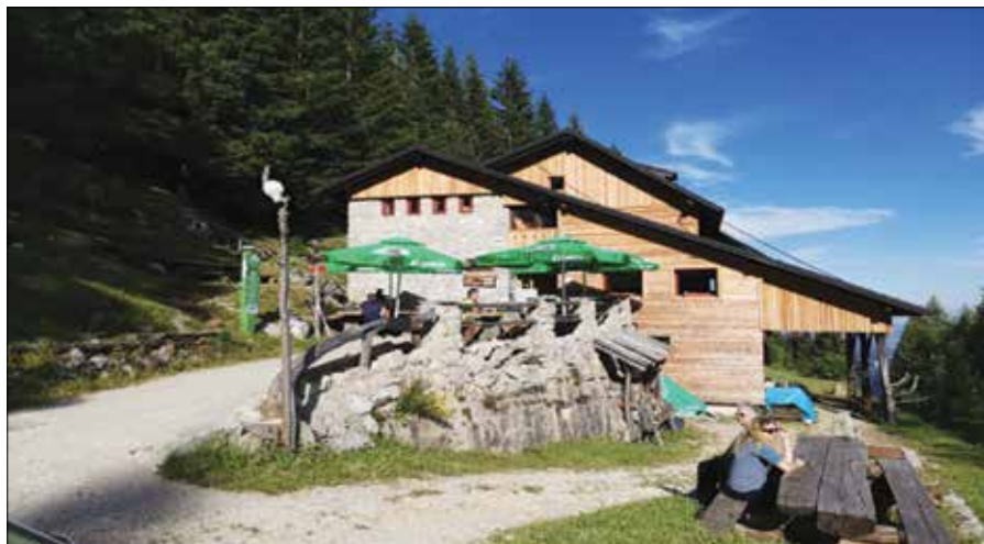
Mozirski planinci so v zadnjih letih temeljito obnovili kočo.
