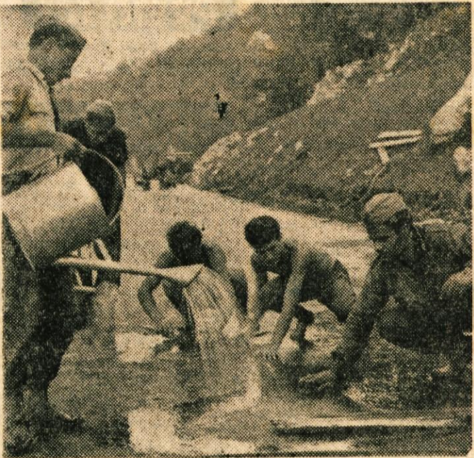
Ribanje asfaltne ceste ni sramotno delo, brigadirji so se ga vedno lotili s posebnim veseljem, posebno zadnje dni v minulim tednu, ko je bilo tudi to delo končano...
