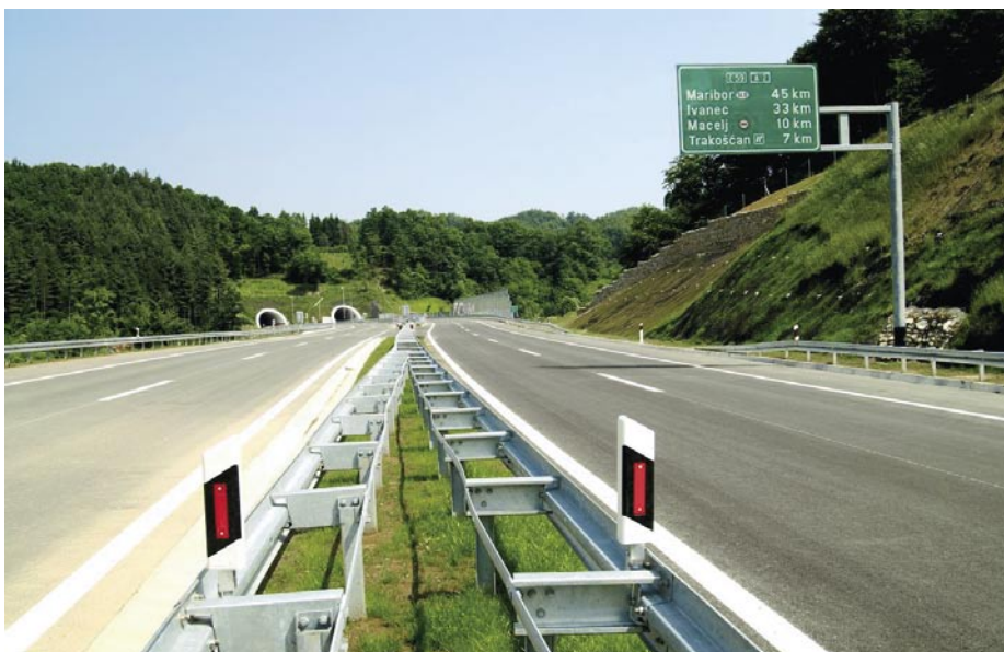
Slika 3 • Avtocesta Zagreb–MMP Macelj na čezevropskem prometnem koridorju X.c na odseku phyrnske avtoceste med Mariborom in Zagrebom (Vir: AZM Autocesta Zagreb–Macelj)
