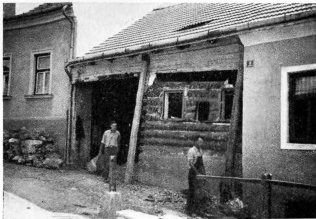
Novo mesto: Ulica 6. septembra (Tesarska ulica). Milačeva hiša (Stena prvotne mežnarije pri cerkvi sv. Jurija; mala okenca — srednje še vidno — so bila pred kakimi petdesetimi leti zabita in izrezana večja. Podrto dne 5. avgusta 1938.)
