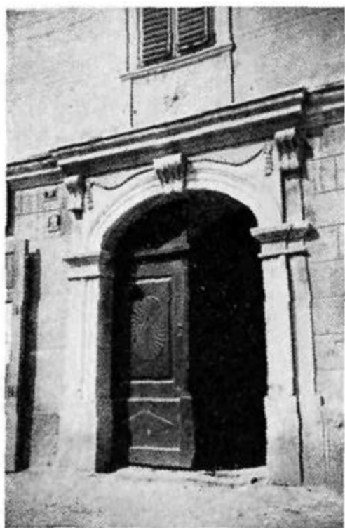
Novo mesto: Trg kralja Petra II. (Glavni trg). Portal Germove hiše
