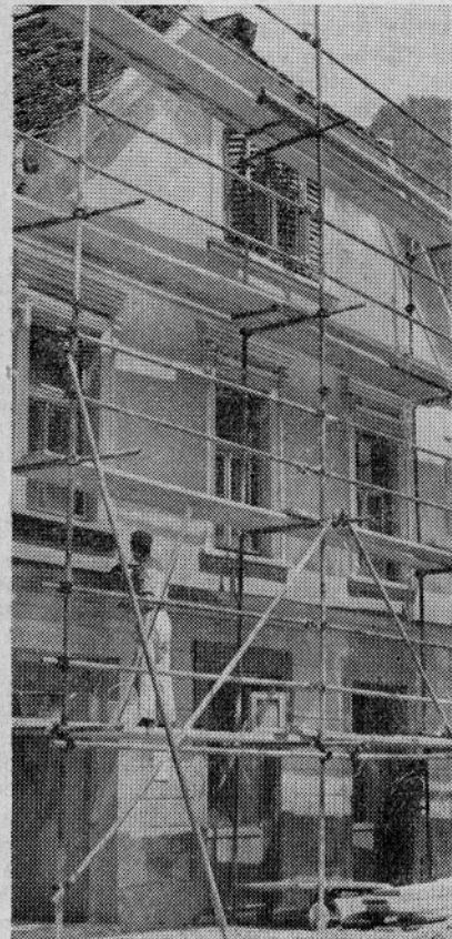
OBNOVA HIŠE LAŠKO 172
