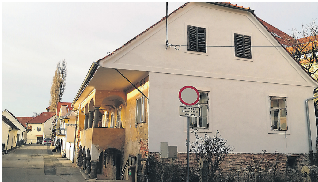
Obnovljena je fasada na delu stavbe, ki gleda na ulično stran, za celovito obnovo bo treba počakati na kulturnovarstveno soglasje.
