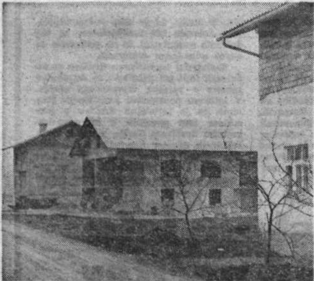
V Dolu je zadnji čas zraslo precej novih stavb, ki pa nosijo naziv »črne gradnje«, saj lastnikom, kljub precejšnjemu trudu še ni uspelo dobiti ustreznih dovoljenj.
